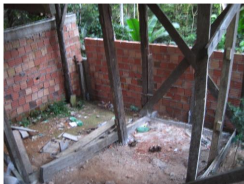
Presidente Figueiredo Construction
